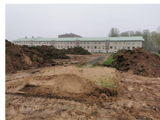
Kauaoodatud staadioni renoveerimise algus kevadel 2021
