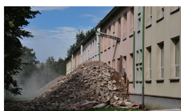
Uues majas jäid renoveerimise alguses alles vaid seinad. Foto: Toomas Uudeberg
